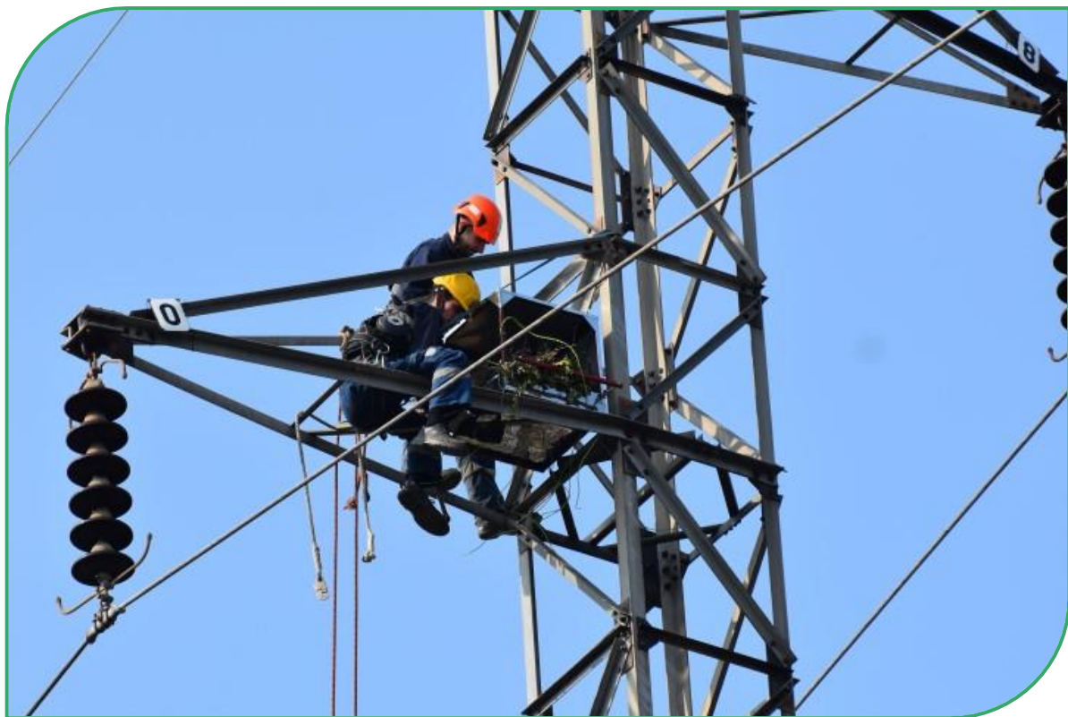
Слика 8: Постављање алуминијумске кутије за гнежђење степског сокола на далеководу типа „јела“ у Банату, 2022. година.
