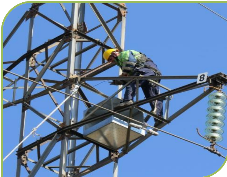
Слика бр. 15: Постављање алуминијумске кутије за гнежђење степског сокола на далеководу типа „јела“ у Бачкој, септембар 2021. године.
